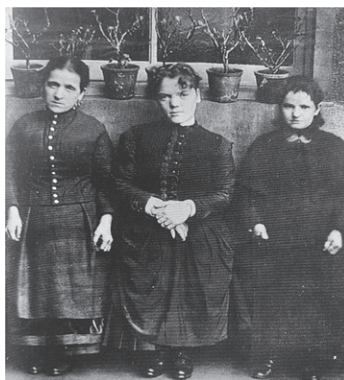
Фото 1. Перші три випадки виконання планового кесарева розтину у пацієнок з рахітом зі значними деформаціями таза (підвіконня, на якому стоять горщики з квітами, має висоту близько 1 м)
