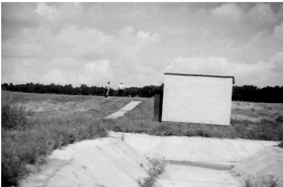
Рис. 1. Приміщення гідрометричного поста
