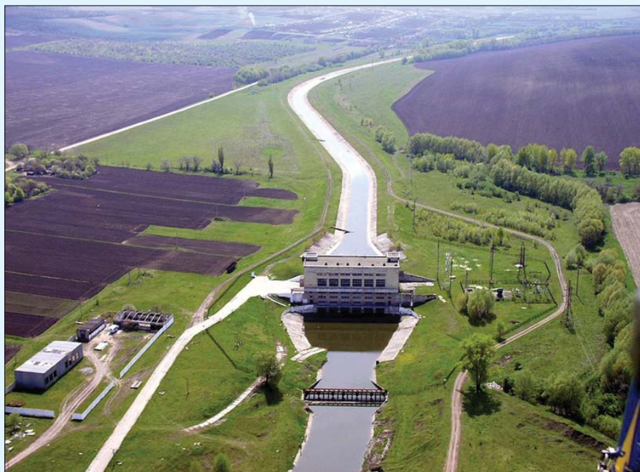
Насосна станція каналу Дніпро-Інгулець
