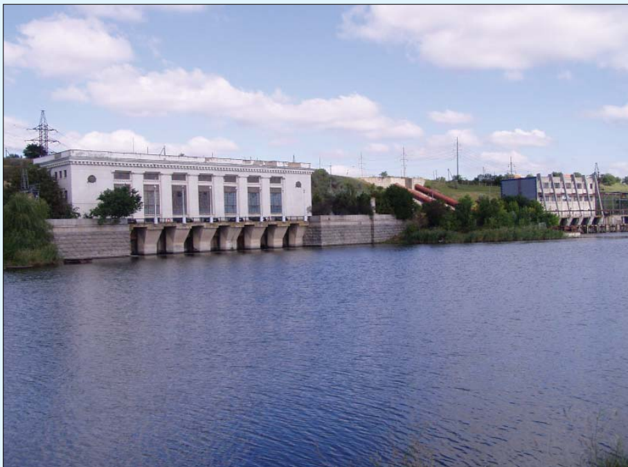
Насосна станція Інгулецької зрошувальної системи
