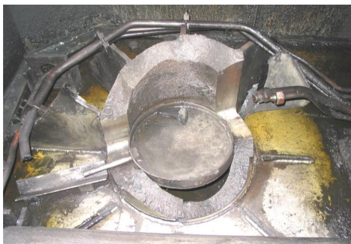
Рис.3. Характер разрушения на участке сопряжения колонны со станиной
