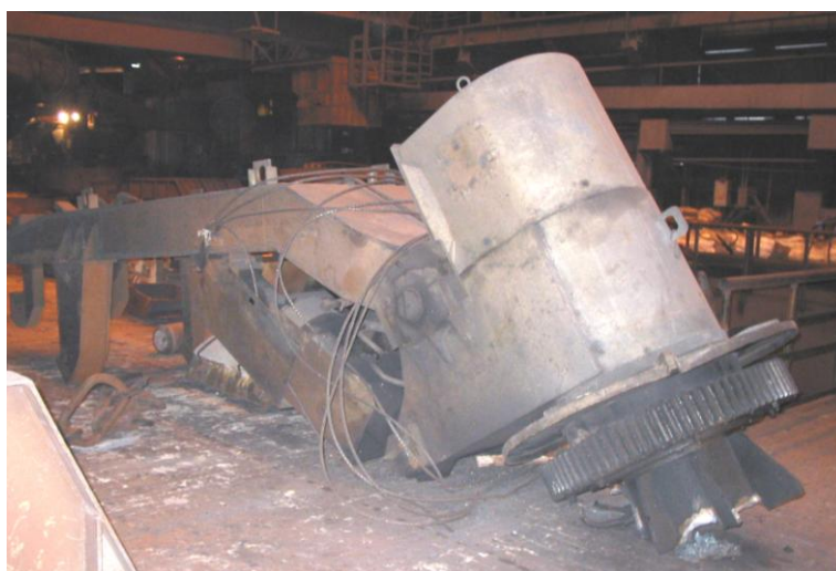
Рис.2. Общий вид аварийного обрушения манипулятора
