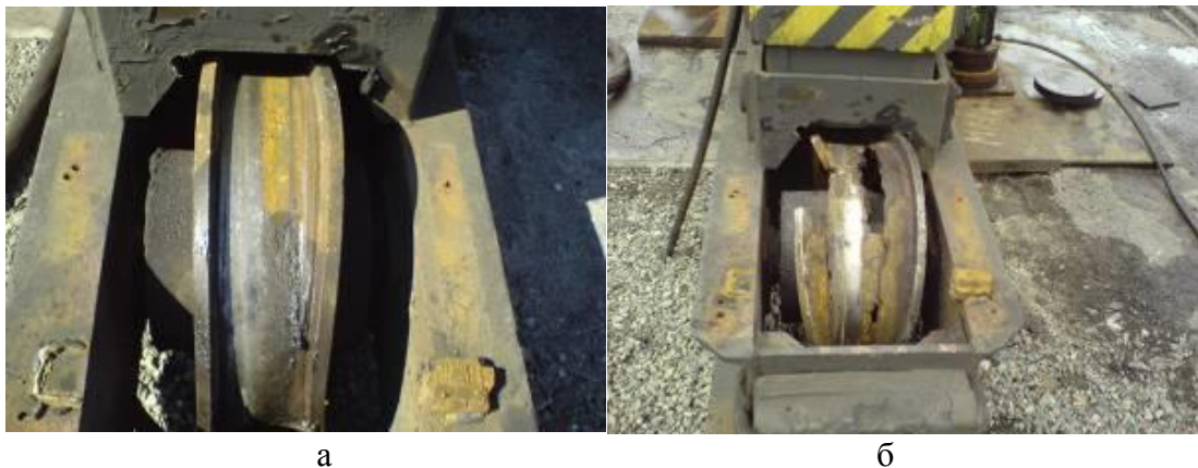
Рис. 1 – Виды износа ходовых колес портального крана: а - отслоение поверхности катания, деформация реборды; б - разрушение колеса.
