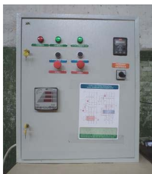
а) перетворювач частоти електричного струму Danfoss
