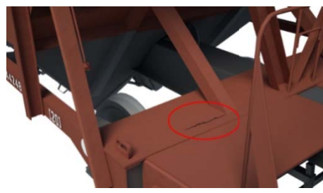
е) Поздовжні тріщини в балках рами
