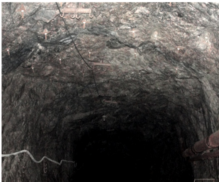
Рис. 2. Шахта Новоконстантиновская, гор. -240 м. Сопряжение вентиляционного квершлага и орта 41+50. Оконтуривание выработки по естественным поверхностям ослабления, шелушения в углах сопряжения трещин не наблюдается, уровень напряжённого состояния \eta \leq 0,12
