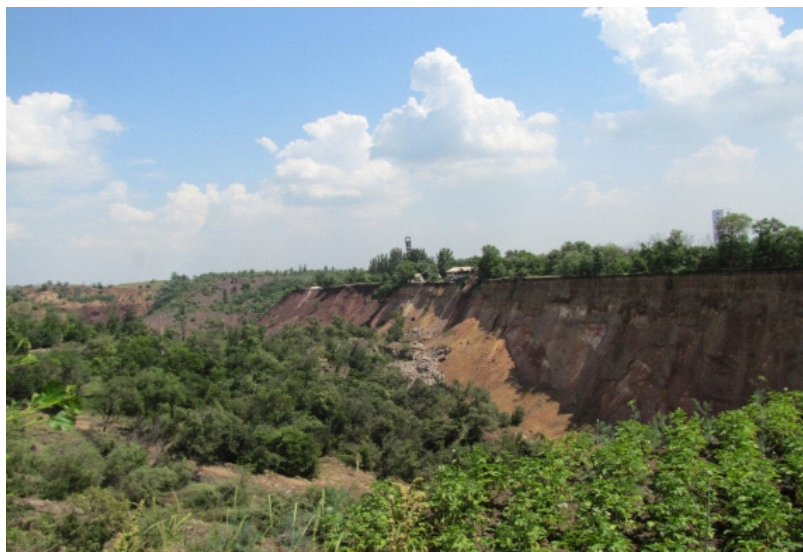
Рис.4. Зона обрушения на развитой стадии горных работ
