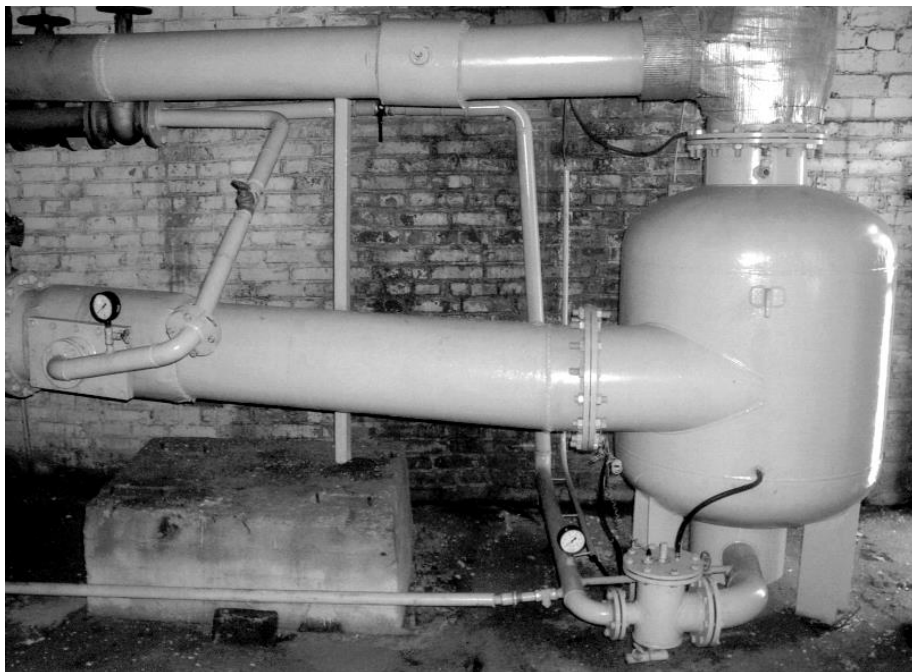
Рис. 3. Промышленный контактный воздухоохладитель рудничного турбокомпрессора типа ВКС-500
