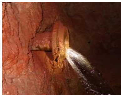
Рис. 10. Водоприток по скважине 70 по состоянию на 10.02.2015
