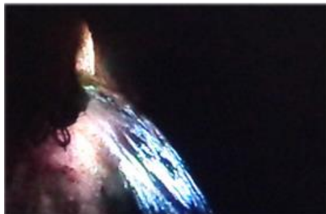
Рис.11. Водоприток по скважине 70 по состоянию на 09.06.2015
