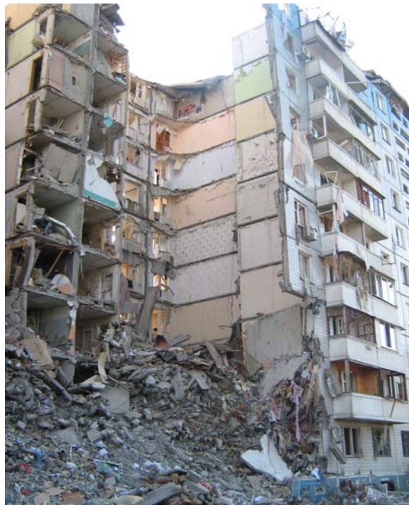
Рисунок 1 – Секция дома, разрушенная взрывом газа
