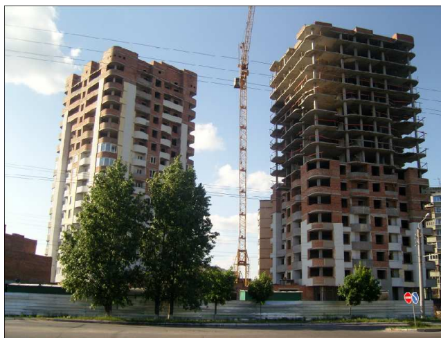
Рис. 4. Загальний вигляд двох 16-поверхових житлових будинків, що знаходяться в процесі зведення
