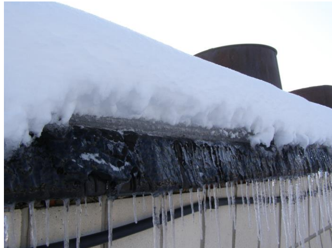
Рисунок 1 – Результат підтавання снігу на покритті
