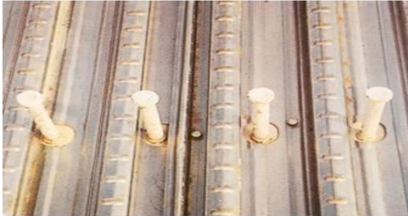
Рисунок 2 - Гнучкі анкери по профнастилу
