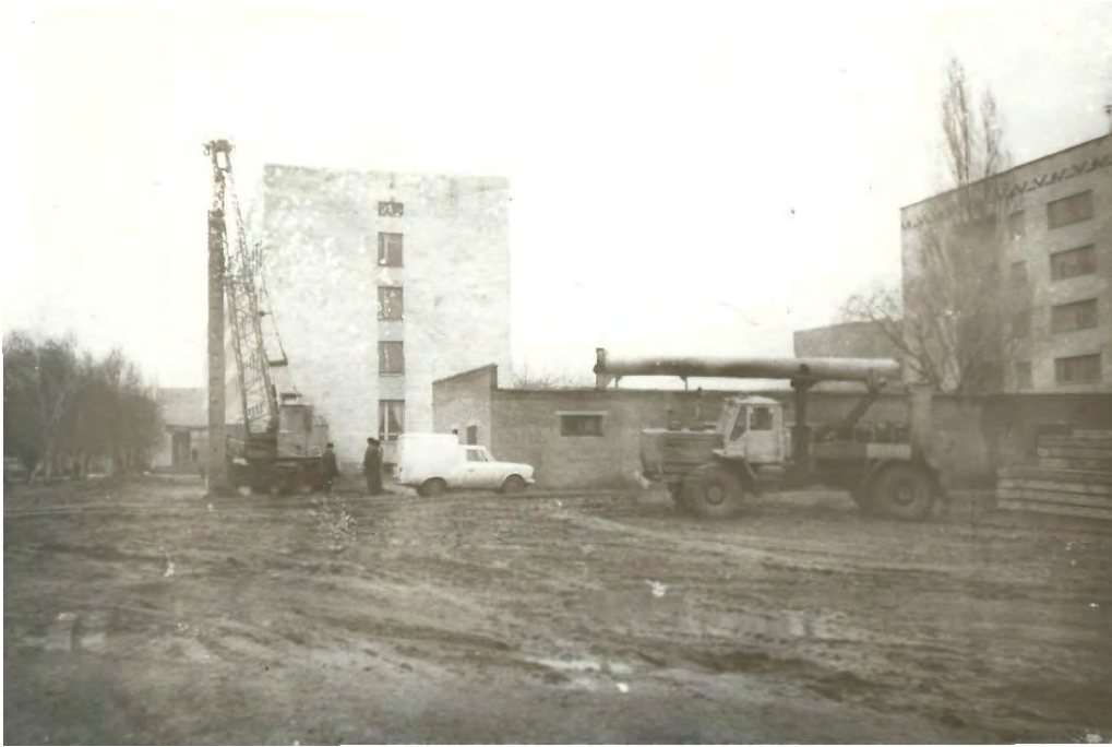
Рисунок 3 – Машини, створені для виготовлення фундаментів у пробитих свердловинах
