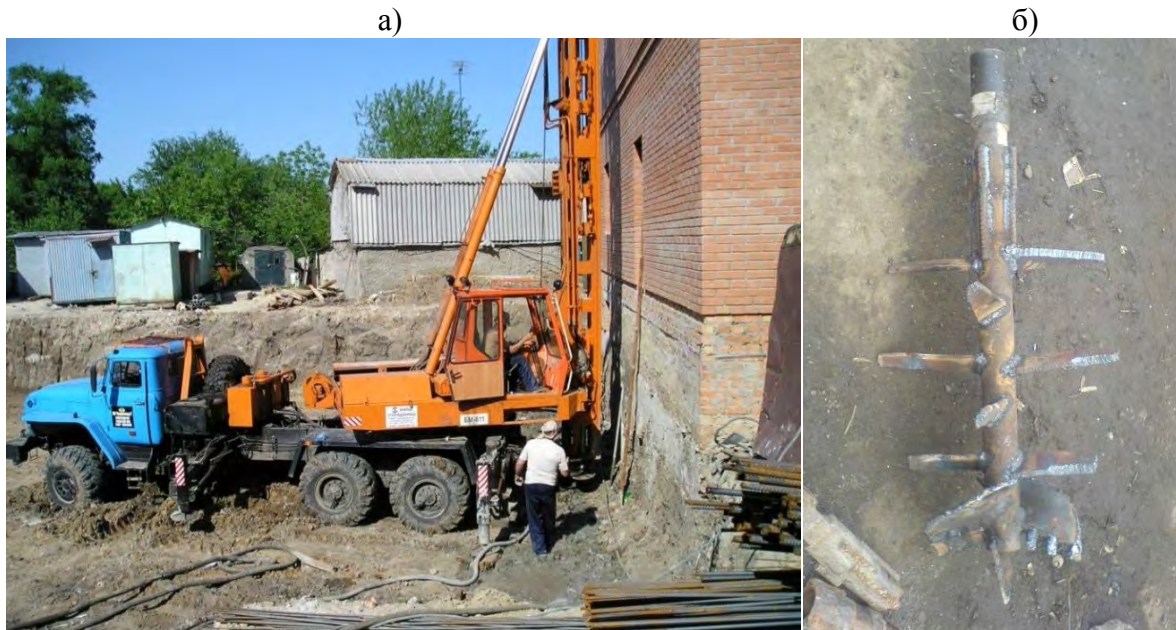
Рисунок 6 – Обладнання для виконання бурозмішувальних робіт: а) бурова машина БМ-81М; б) долото
