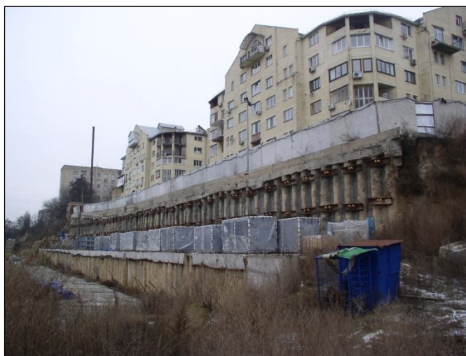
Рисунок 1 – Общий вид подпорных стен на участке строительства
