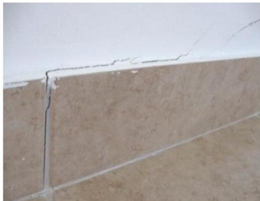
*Рисунок 5 – Раскрытие трещин по стене и по швам облицовочной плитки на балконе*
