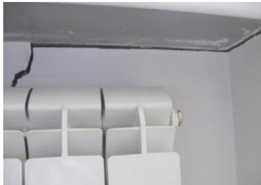
*Рисунок 2 – Трещина на несущей стене*
