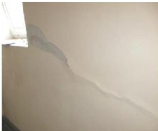
*Рисунок 6 – Раскрытие трещин со смятием штукатурки по наружной стене лестничной клетки*
