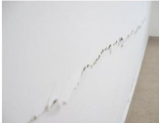
*Рисунок 4 – Нарушение целостности гипсокартонной облицовки наружной стены*
