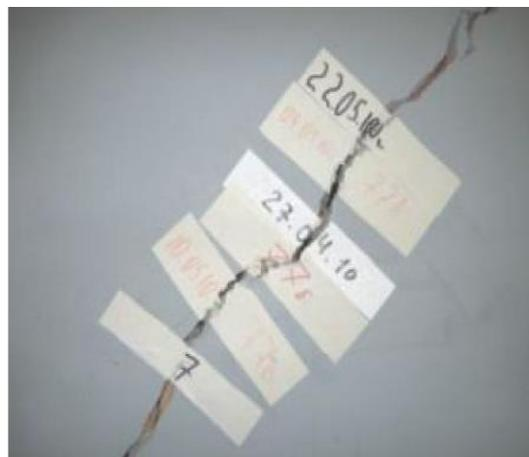
*Рисунок 3 – Раскрытие трещин на стене в паркинге*
