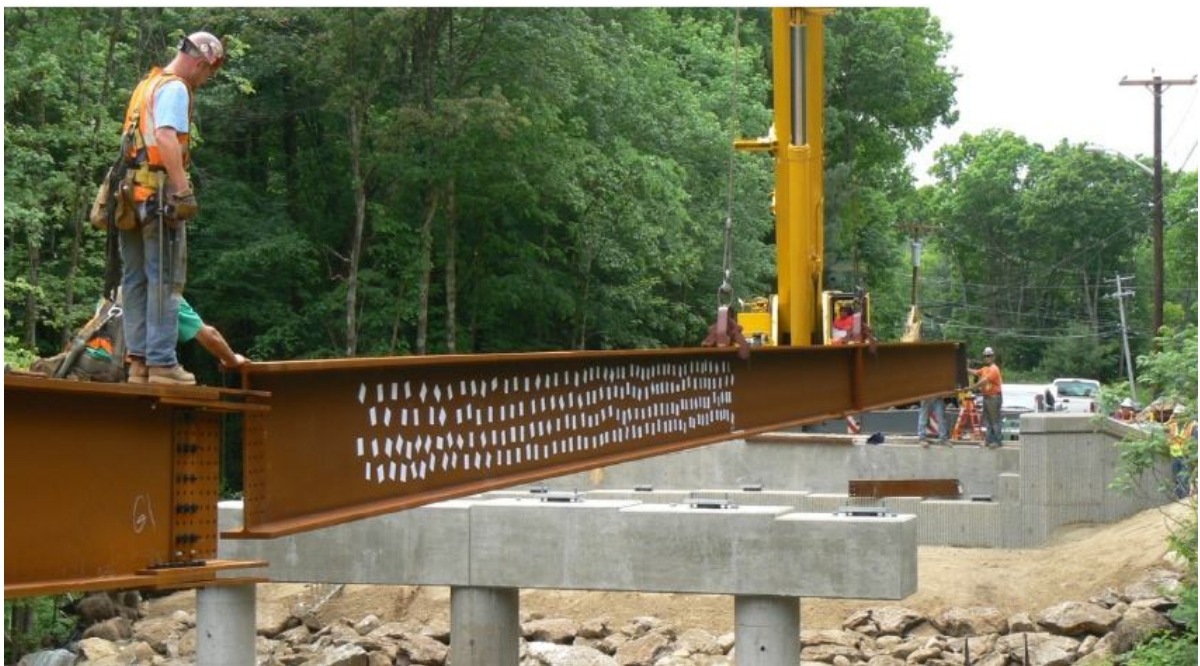
Рисунок 6 – Східна зовнішня балка з Vernon Avenue Bridge зі спеціальною обробленою зоною під час монтажу
