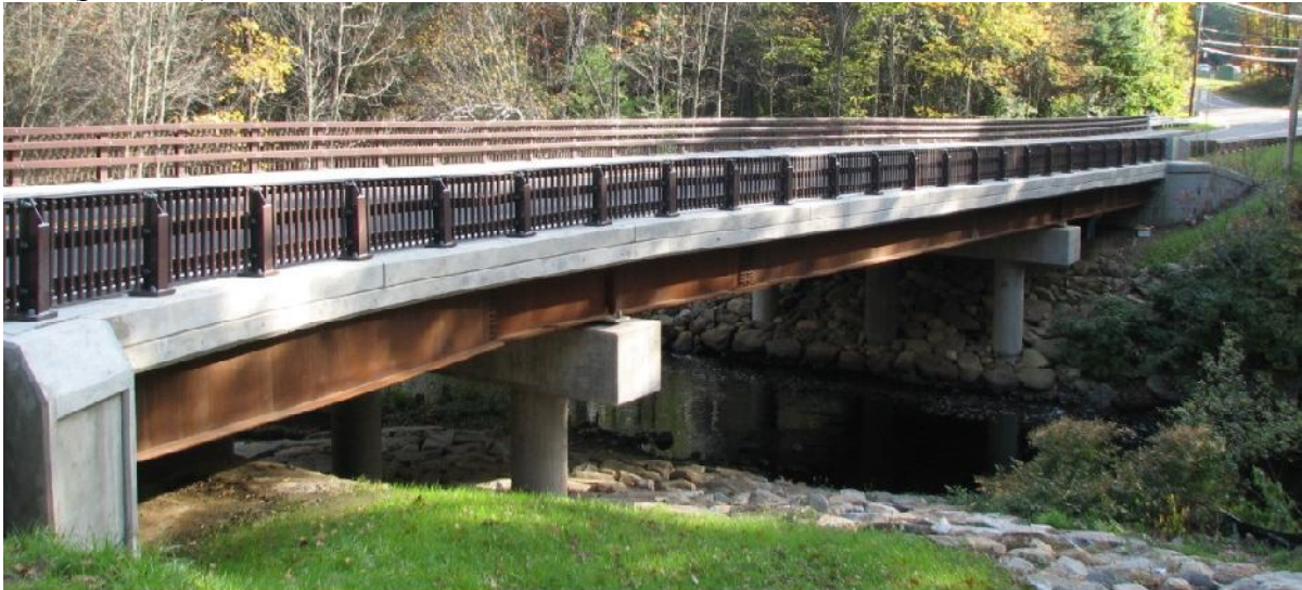
Рисунок 5 – Вид на мосту Vernon Avenue Bridge
