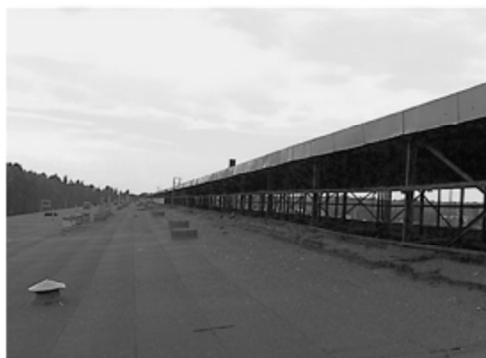
Рис. 2. Загальний вигляд конструктивного рішення покриття і літтарної надбудови будівлі ремонтно-екіпірувального депо до проведення їх реконструкції
