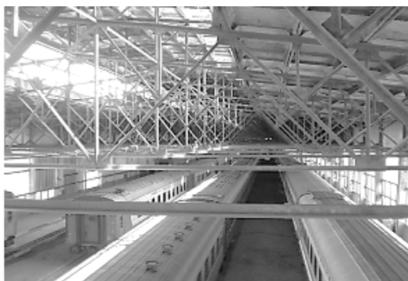
Рис. 2. Загальний вигляд конструктивного рішення покриття і літтарної надбудови будівлі ремонтно-екіпірувального депо до проведення їх реконструкції
