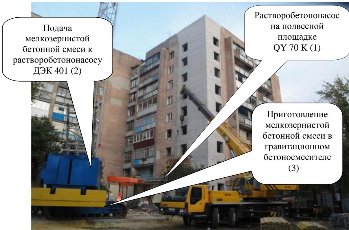
**Рис. 3. Технологическая схема использования двухпоршневого растворобетононасоса**
