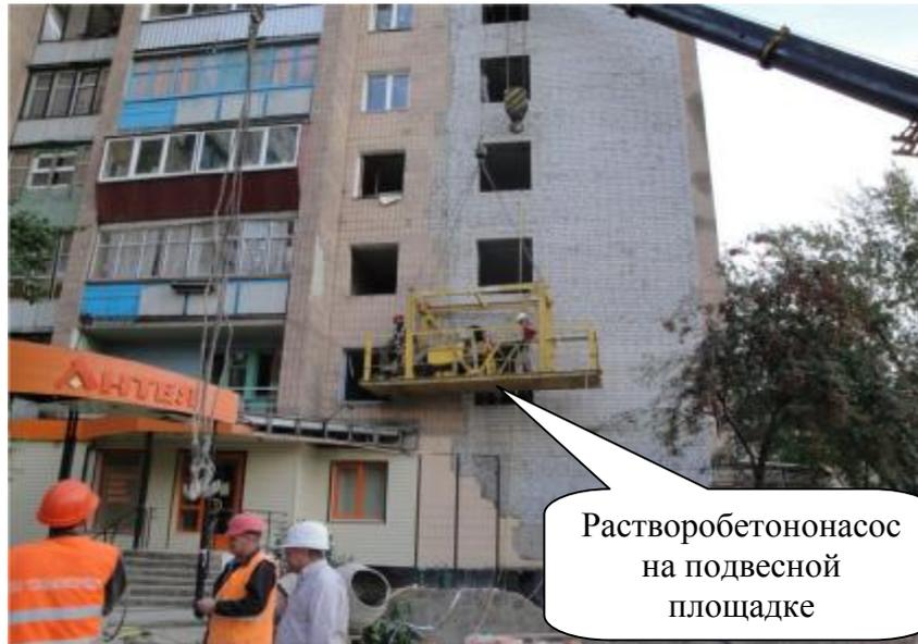
**Рис. 3а. Растворобетононасос на подвесной площадке**
