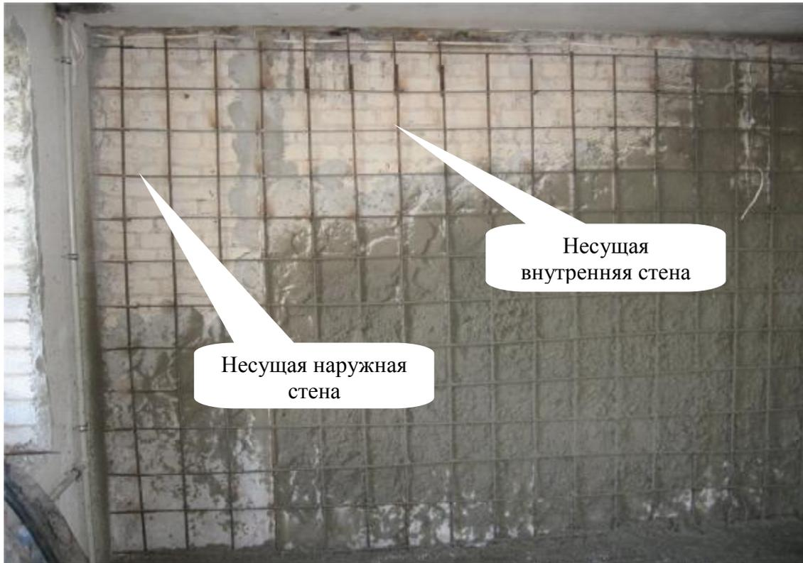
**Рис. 2. Усиление стен за счёт применения дополнительного армирования**
