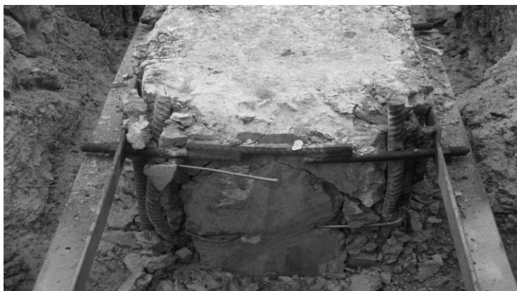
Рис. 10. Свая № 173 после испытания
