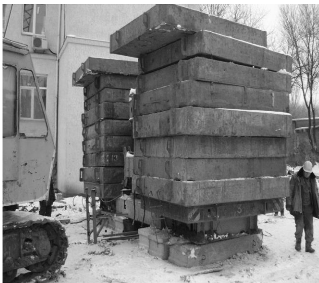
Рис. 5. Площадка испытания сваи № 104
