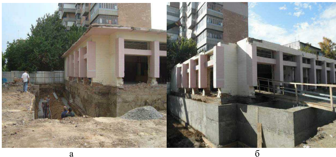
Рис. 3. Стан виконання робіт: а – на момент першого циклу нівелювання; б – на момент другого циклу нівелювання
