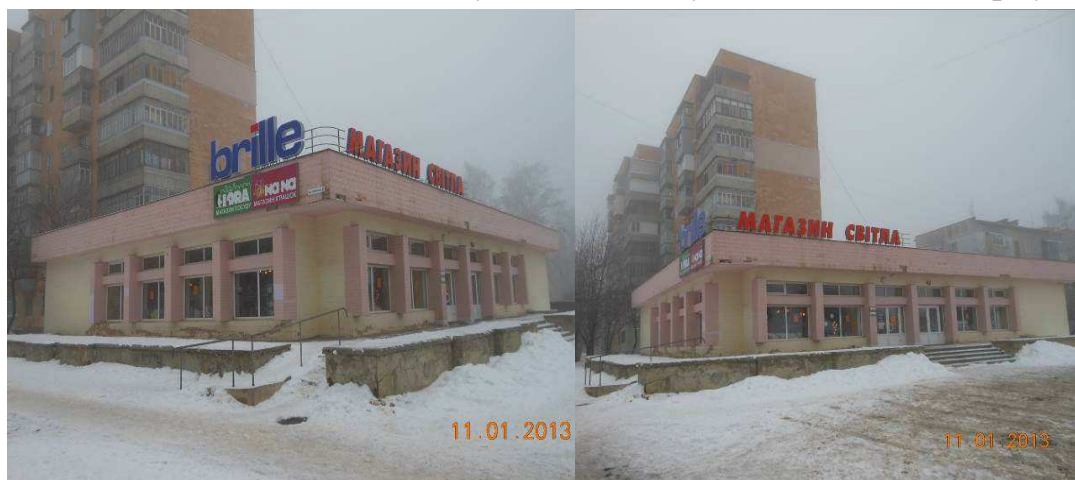
Рис. 1. Загальний вигляд одноповерхової будівлі по вул. Грушевського, 21 у м. Полтава до початку робіт з реконструкції
