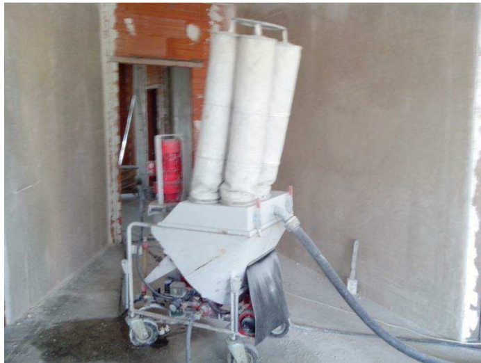
Рис. 3. Штукатурна станція для приготування та нанесення розчинової суміші
