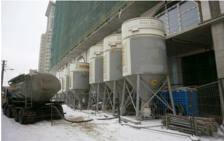
Рис. 7. Заправка силоса сухою сумішшю
