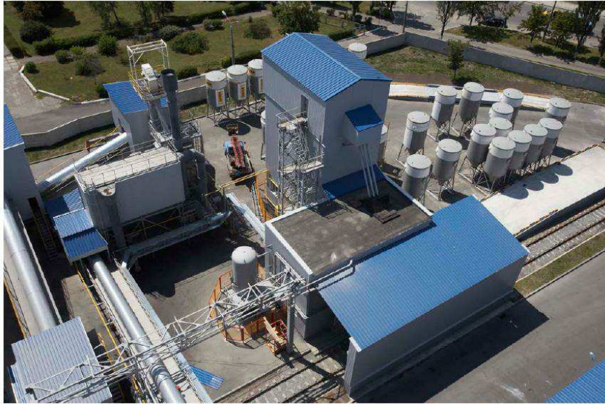
Рис. 3. Завод з виробництва сухих будівельних сумішей «Термінал-М»
