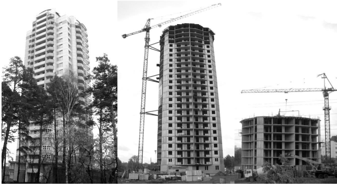
Рис. 7. Зведена 26-поверхова житлова будівля по вул. Залеського та 28-поверховий будинок по вул. Виборній і 18-поверховий будинок по вул. Р. Зорге, що будуються
