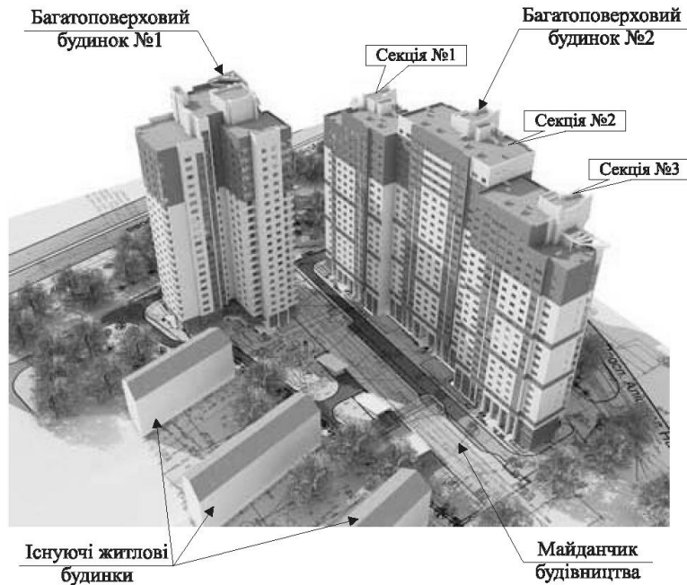
Рис. 1. Загальний вигляд багатоповерхових будинків на майданчику будівництва
