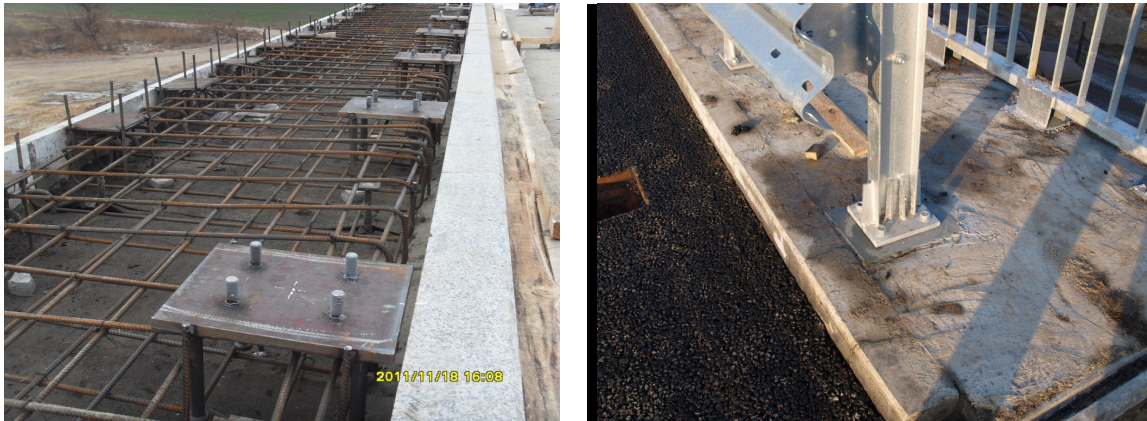
Рис. 5. Закладні деталі бар'єрного огородження шляхопроводу
