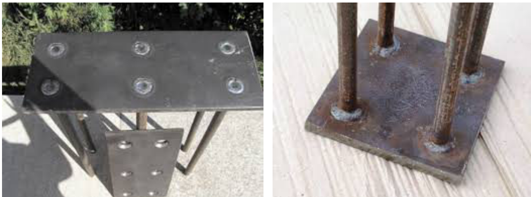
Рис. 1. Загальний вигляд закладних деталей, виготовлених у заводських умовах
