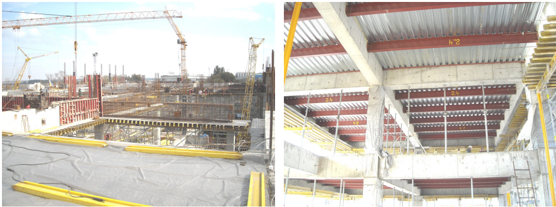
Рис. 3. Сталезалізобетонне перекриття нового терміналу в аеропорту міста Донецьк
