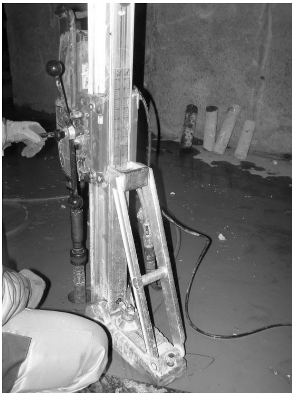
Рис. 2. Буріння фундаментної плити установкою Hilti буром 100 мм
