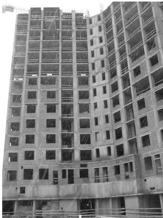
Рис. 1. Вигляд будівлі під час обстеження
