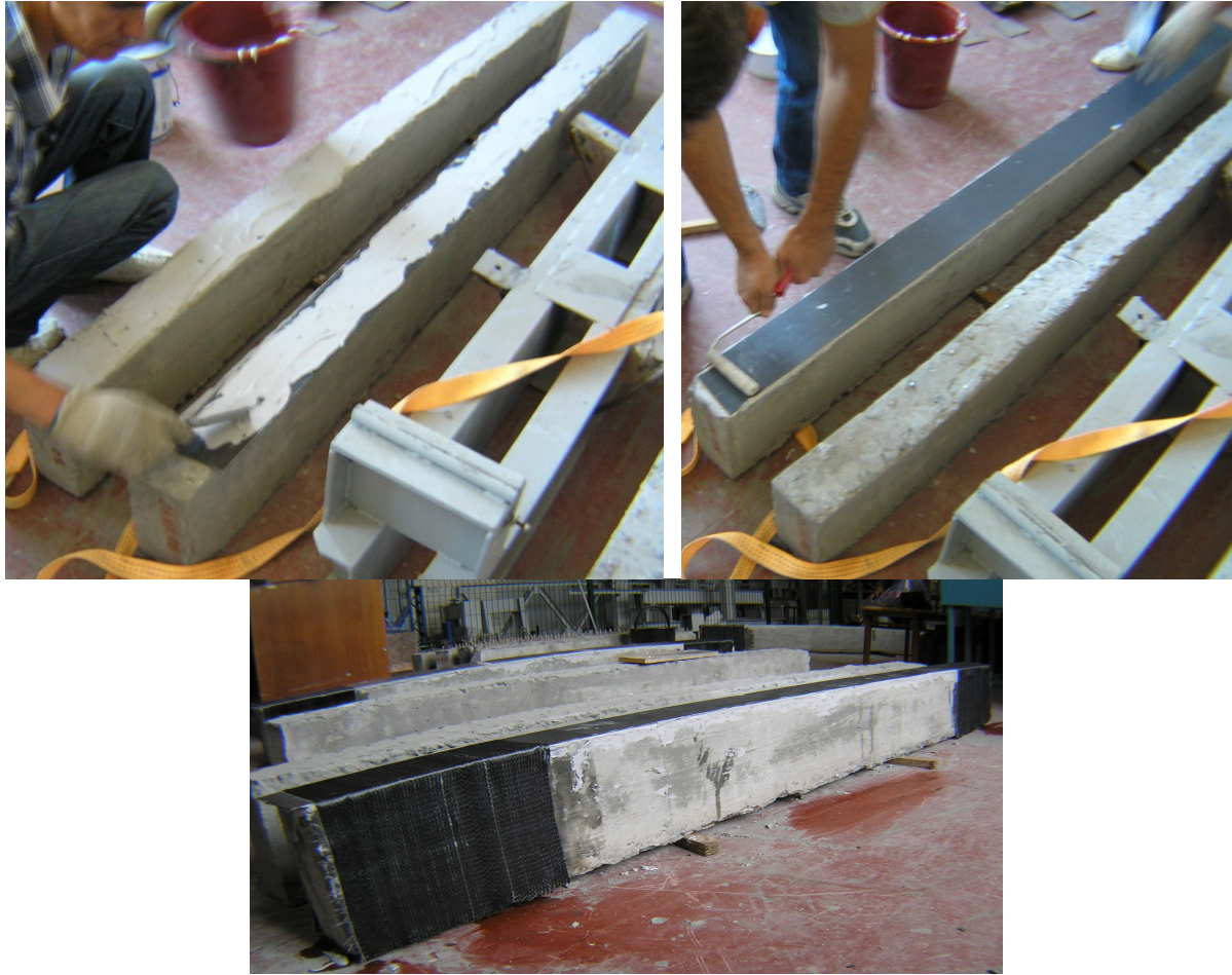
Рис. 2. Приклеювання елементів підсилення
