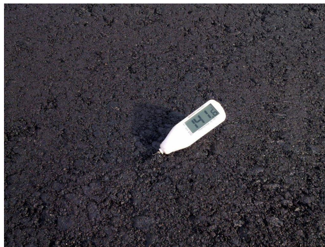
Рис. 5. Измерение температуры смеси внутри слоя асфальтобетона
