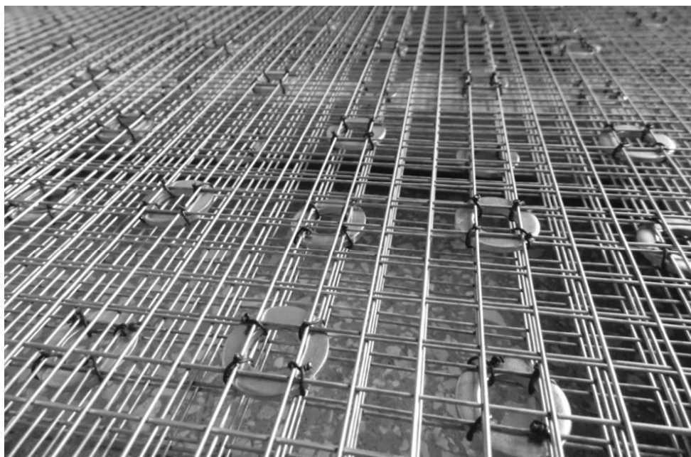
Рис. 1 – Арматурні сітки плити
