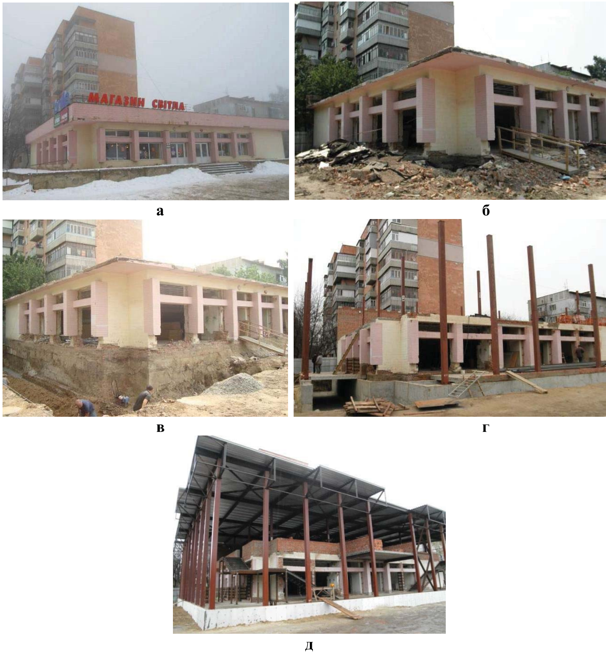
Рис. 1 – Стадии реализации процесса реконструкции одноэтажного здания, соответствующие циклам нивелирования при наблюдениях за деформациями его основания: а – 0-й; б – 1-й; в – 2-й; г – 3-й; д – 4-ый
