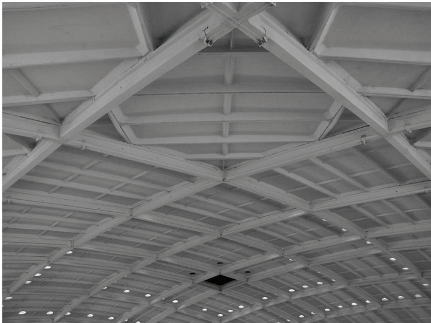
**Рисунок 2 – Збірні елементи залізобетонної оболонки**
