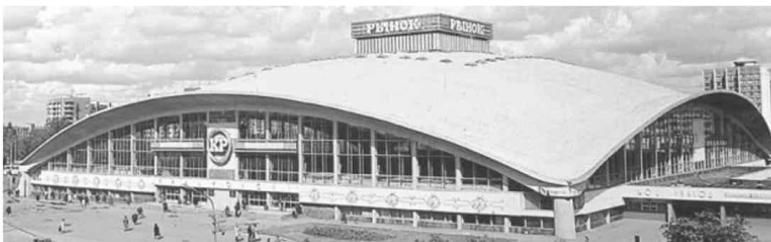
**Рисунок 3 – Залізобетонна оболонка з додатковими стійками**
