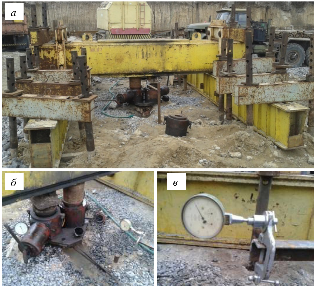
Рисунок 2 – Анкерний стенд для випробування одиночної палі: а – загальний вигляд стенду, б – подача води для замочування ґрунту та передача навантаження на палю від двох домкратів, в – прогиномір БПАО.
