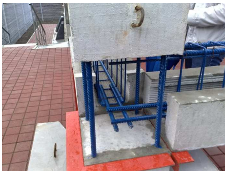
Рис. 1 Вузол з'єднання ригеля з крайньою колоною в ЗМК Сарет
