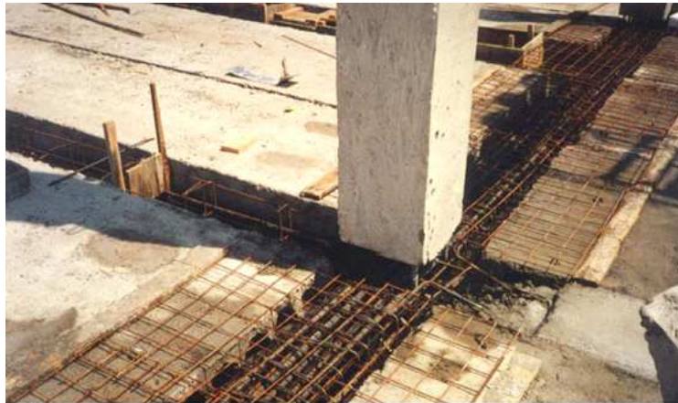
Рис. 3 Вузол сполучення збірних багатопустотних плит з монолітними ригелями в ЗМК Аркос
