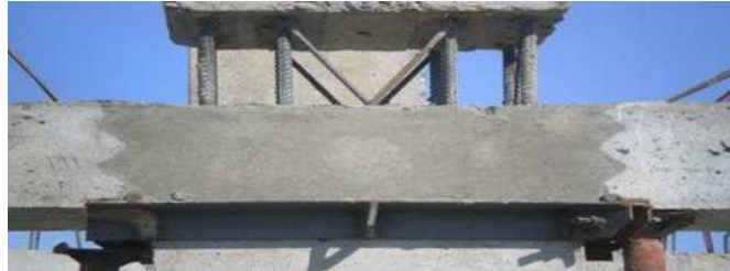
Рис. 2 Шпонковий стик ригеля з колоною в ЗМК Казань XXI ВЕК
