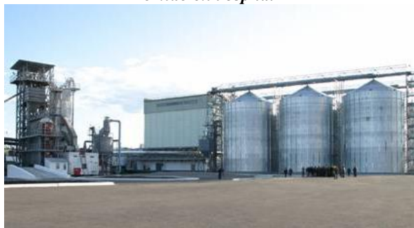
Рис. 4. Элеватор с железобетонными и стальными силосами.
