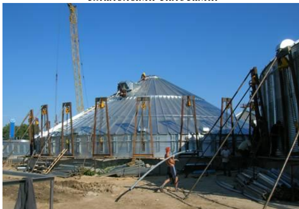
Рис. 5. Начало монтажа металлического силоса.
