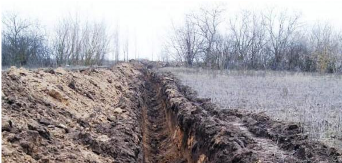
Рисунок 8. Зруйнована зрошувальна мережа в Придунайському регіоні
