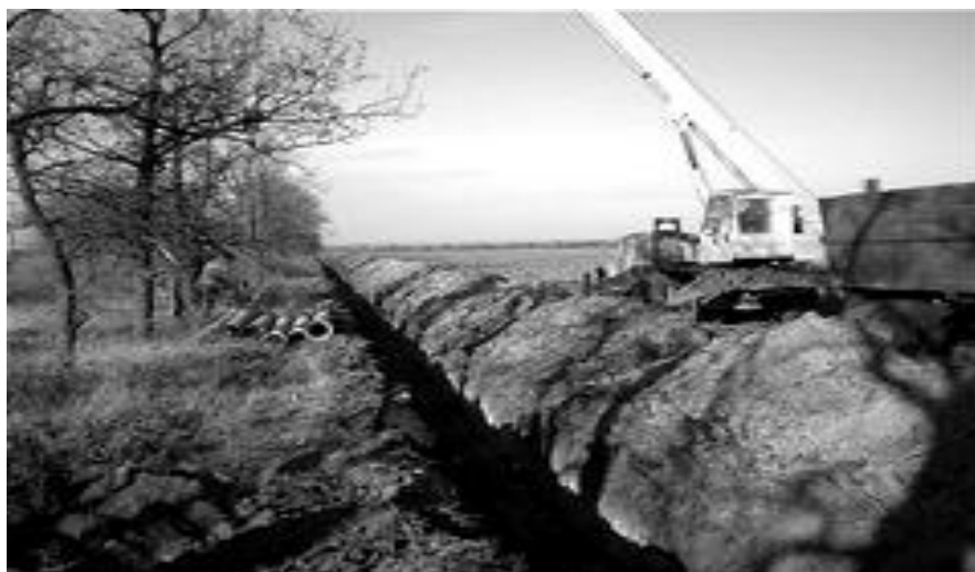
Рисунок 4. Демонтаж зрошувальної мережі у Миколаївській області
