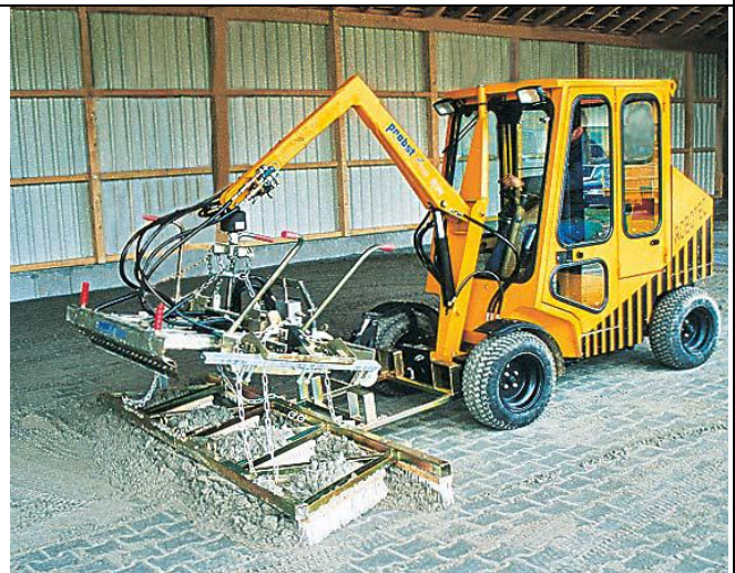
Заповнення швів навісними щітками
