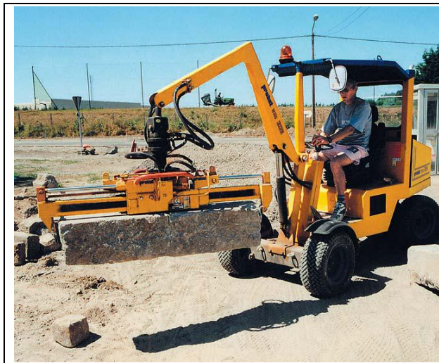
Встановлення бордюрних каменів за допомогою автоматичного захвату
