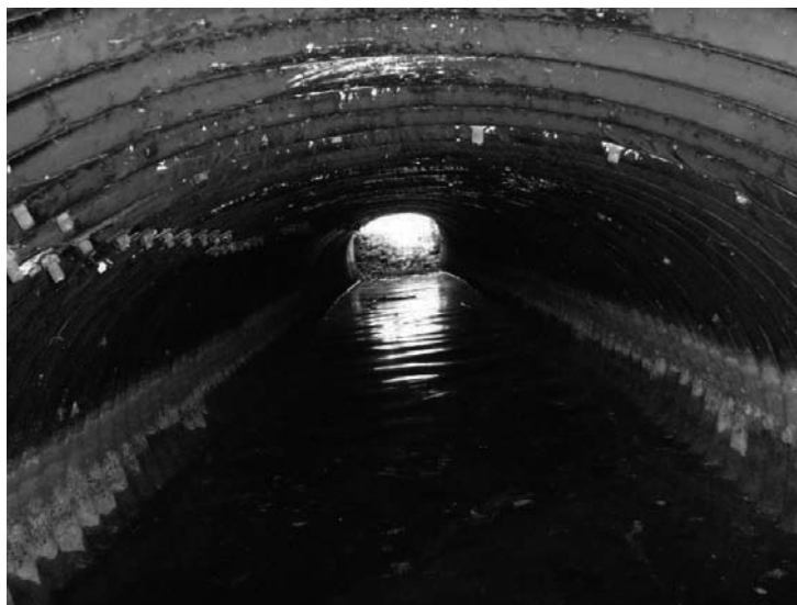
Рисунок - 3 Овализация тела трубы
