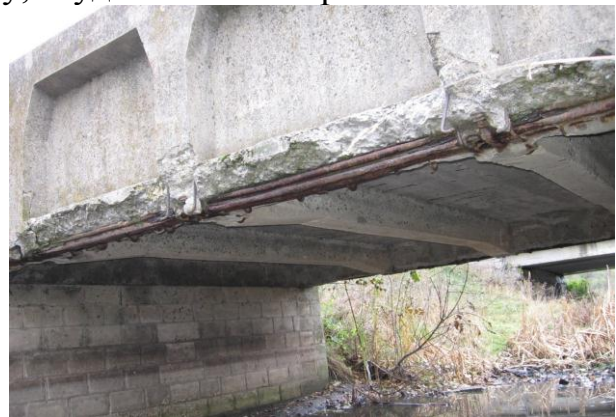
Рисунок 1 - Монолітна цементобетонна аркова труба біля ст. Сенча Миргородського району, збудована в 1894 р.
