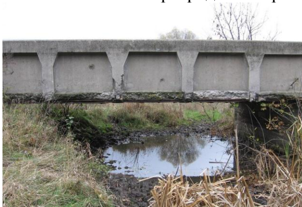
Рисунок 1 - Монолітна цементобетонна аркова труба біля ст. Сенча Миргородського району, збудована в 1894 р.
