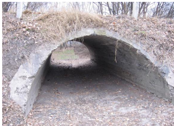
Рисунок 1 - Монолітна цементобетонна аркова труба біля ст. Сенча Миргородського району, збудована в 1894 р.
