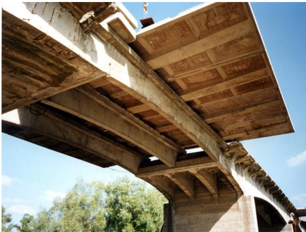
Рисунок 4 - Збірно-монолітний залізобетонний міст через р. Ворскла біля с. Білики Кобеляцького району:
