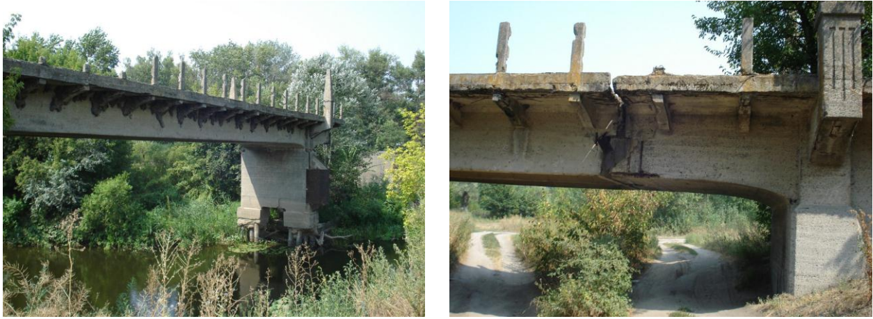
Рисунок 3 - Збірно-монолітний залізобетонний міст через р. Ворскла біля м. Кобеляки, збудований в 1910 р.
