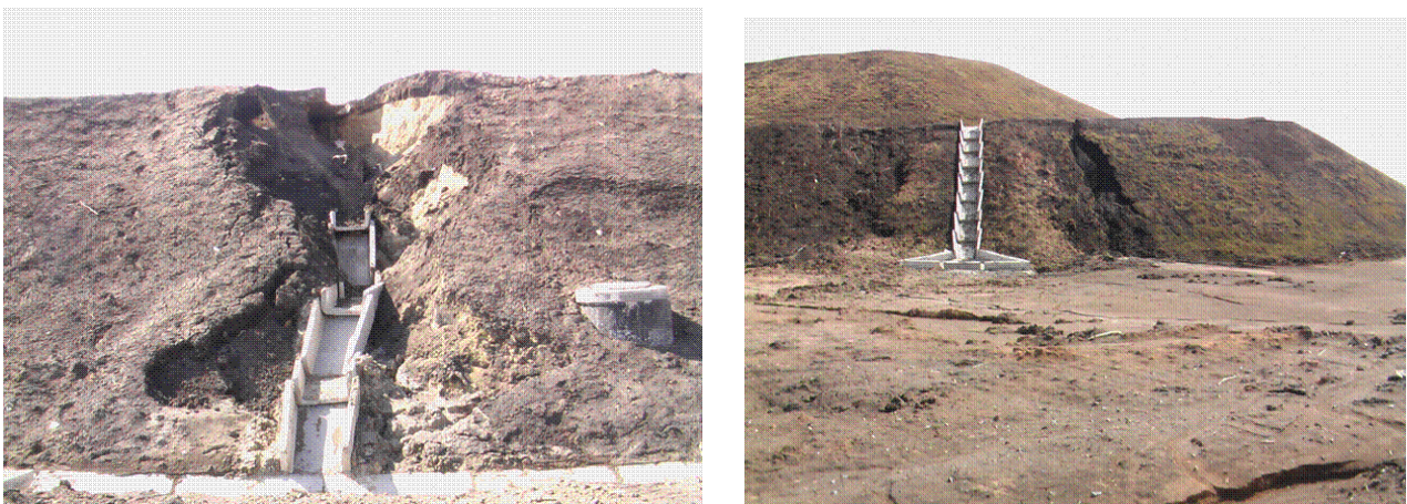
Рисунок 2 - Приклади розвитку розмиву в зоні лотків та за межами лотка при неукріпленні укосу
