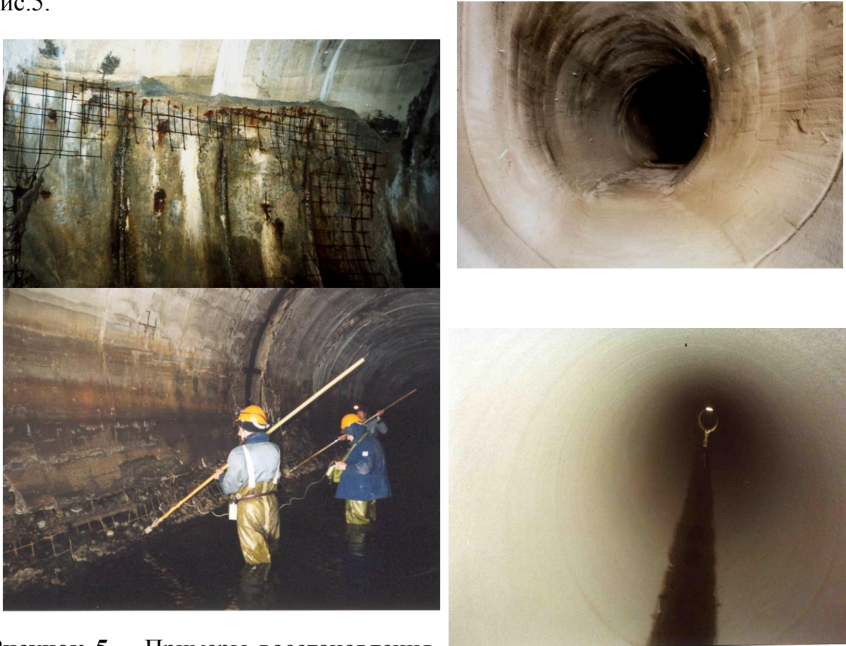
Рисунок 5 – Примеры восстановления железобетона тонкостенных водопропускных сооружений
