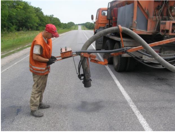
Рисунок 3 – Ремонт покриття пнемоструменевим методом
