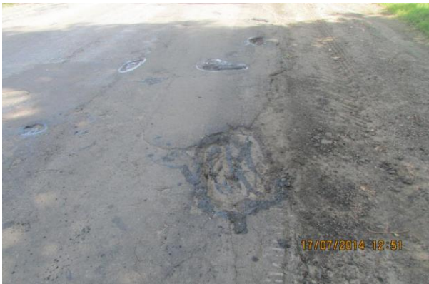
Рисунок 6 – Неякісна підготовка місць ремонту
