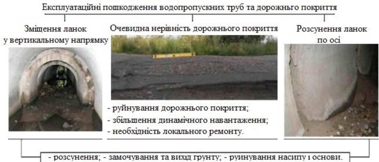
Рисунок 3 – Результати дослідження водопропускних труб на автомобільних дорогах
