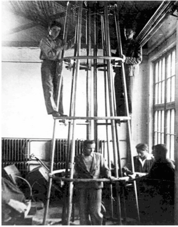
Рис. 7. Монтаж пускового устройства для вертикального старта ракеты. (ХАИ, 1939 г.)
