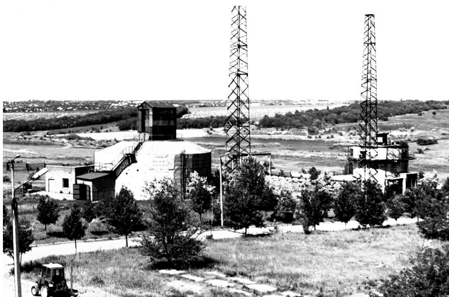
Рис. 1. Взрывные камеры экспериментально-промышленного комплекса сварки взрывом
