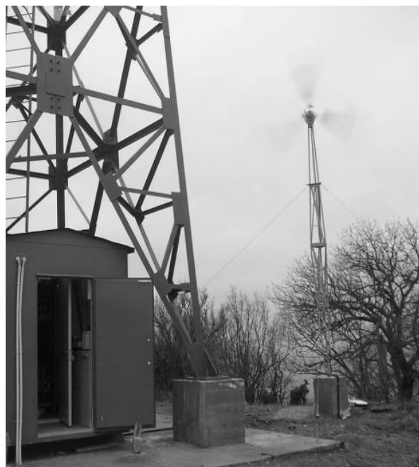
Рис. 3. ВЭУ-075 и контейнер для оборудования
