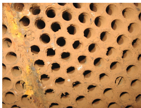
Рис. 3. Вид трубную доску охладителя масла магистрального тепловоза (со стороны воды)
